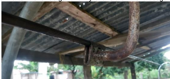
Ilustración 16. Parte inferior de gancho Z y chanela o vincha asegurando el cable
