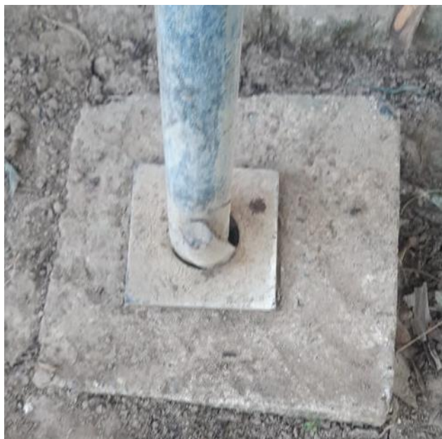
Ilustración 19. Platina base para fijado de tubo galvanizado a bloque correcto
