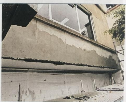
Pañete finalizado en su totalidad
