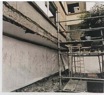
Pañete y arreglo en la fachada
