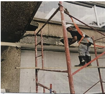
Continuidad del trabajo pañete sobre fachada
