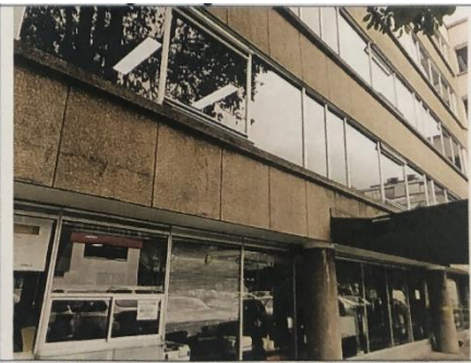
Demolición de fachada granito
