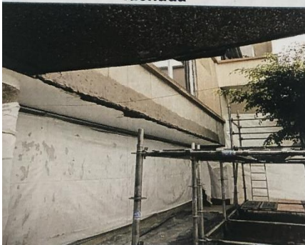
Arreglo de fillos y terminado sobre la fachada
